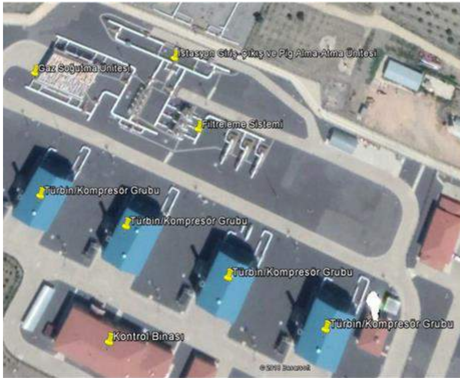
Şekil 1. Endüstriyel Bir Doğal Gaz Kompresör İstasyonu'nu Genel Görünümü
