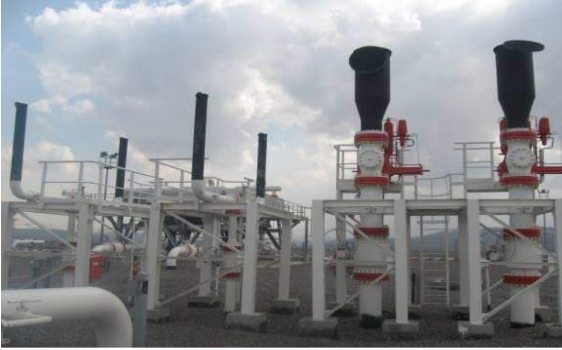
Şekil 7. Tahliye (Relief, Blowdown) Vanaları
