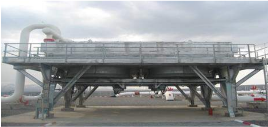
Şekil 6. Gaz Soğutma Sistemi
